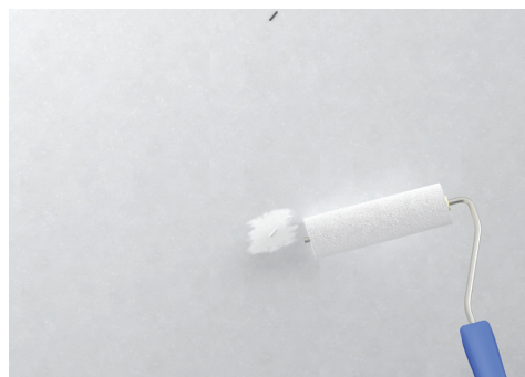
figur 3: Alle klammehuller tætnes med fermacell™ Armeringsklæber eller tapes med AWS tape.
