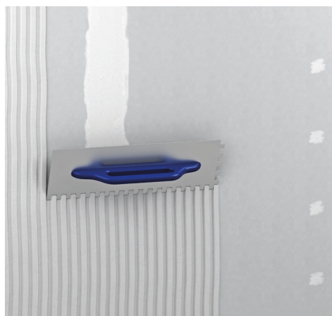
figur 1: Påføring af grundpuds med 12 mm tandspartel.
