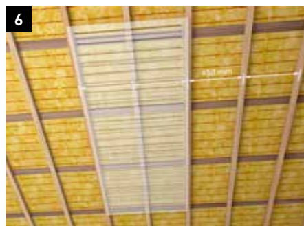
...Alternativt monteres big board parallelt (på langs af) forskallingen c/c 450 mm
