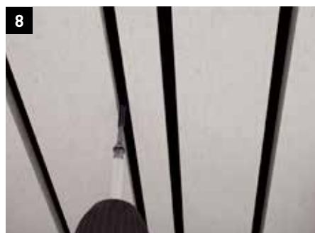
Skrueafstanden i midten er ligeledes maks. 300 mm. Anvend en smal bit-holder for, at undgå skader. Her kan der evt også forbores med et 3,5 mm bor.
