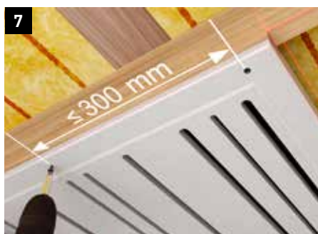
fermacell ACOUSTIC big board skrues op med fermacell Skruer 3,9 x 40 mm langs hele kanten i en afstand på maks. 300 mm. Langs midten skrues der i montagelisten gennem slidserne, så man undgår spartling af skruenhuller.
