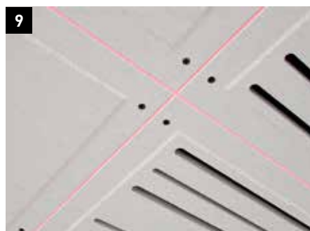
Krydssamlinger anbefales af hensyn til designet. Maksimal feltstørrelse uden dilatationsfuger (bevægelsesfuger) er altid maks. 8,1 m x 8,4 m.
