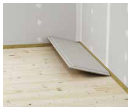
❸ Lægning af fermacell® Gulvelementer.
