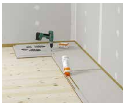
❹ Påføring af fermacell™ Gulvelementlim i falsen.
